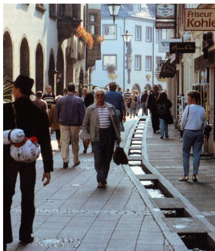
Nyilszíni esővíz-elvezetés Freiburg belvárosában és a malmói Augustenborg lakótelepen
